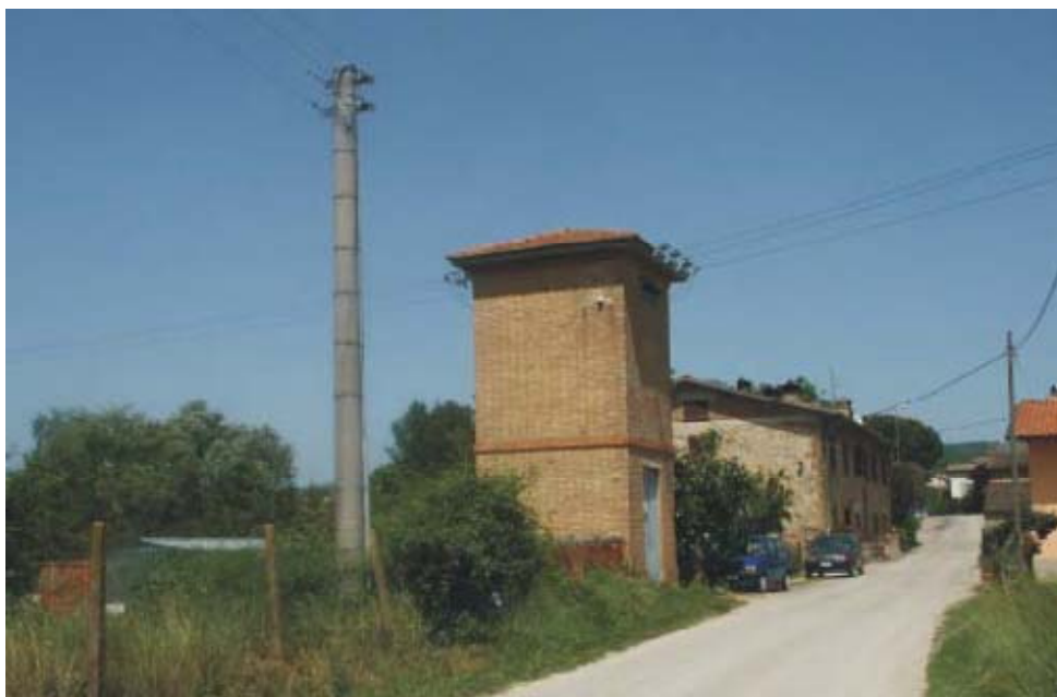
Figura 24: palo e cabina Enel media tensione dove si prevede di realizzare l'allacciamento
