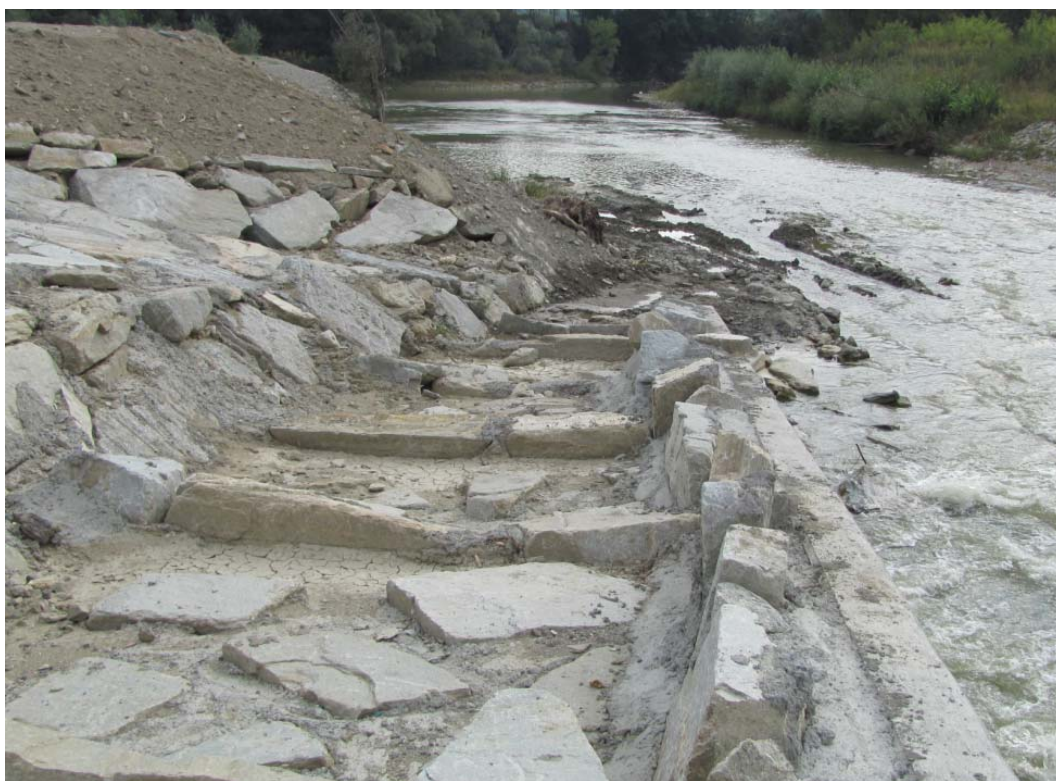
Figura 25: Esempio di rampa di risalita dell'ittiofauna in pietrame
