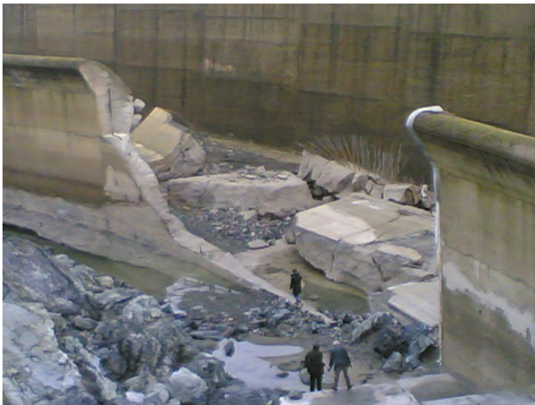
Figura 16 : Parte dello sfioratore di superficie crollato la sera del 27 dicembre 2010
