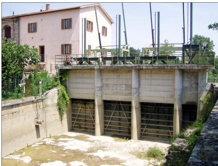
Figura 4: Centrale di Ponte Felcino: dettaglio dello sgrigliatore dell'opera di presa
